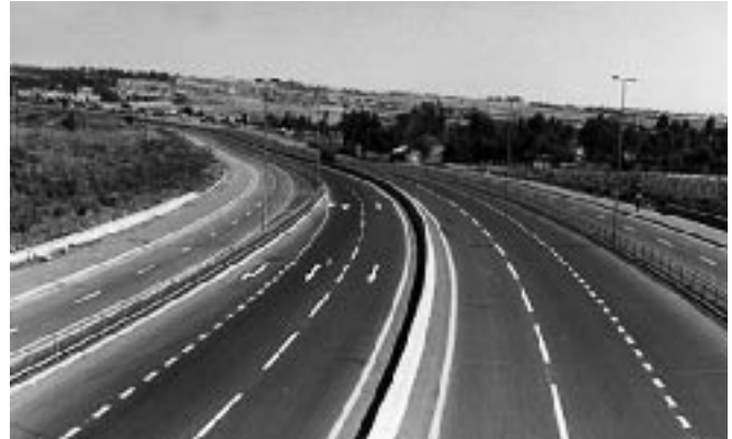
Carretera en Addis Ababa construida por una empresa china
